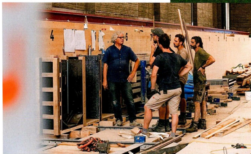
Oben: Das „Lehmhotel Litschau“ soll im Sommer 2025 fertig sein. So kann mehrgeschoßiges Bauen mit Lehm aussehen.
