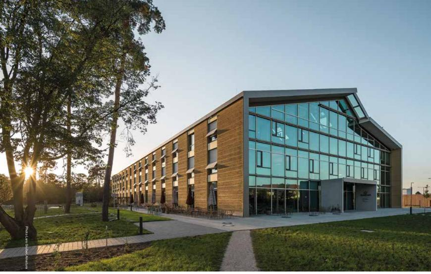
Der Alnatura Campus wurde mit vorproduzierten Stampflehmfertigelementen unter minimaler Verwendung von Beton errichtet. The Alnatura Campus was built with pre-produced rammed earth prefabricated elements, with minimal use of concrete.
